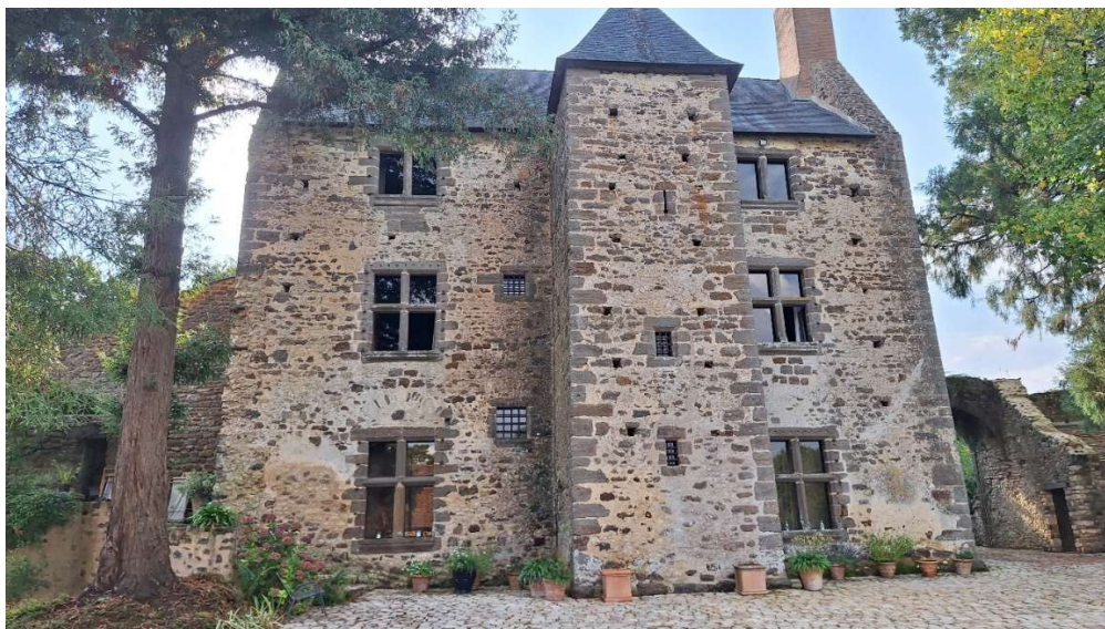
La forteresse du Vieux-Lavardin, à Mézières-sous-Lavardin
